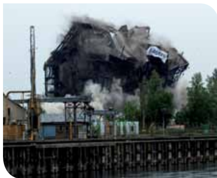
Déconstruction Centrale thermique EDF
