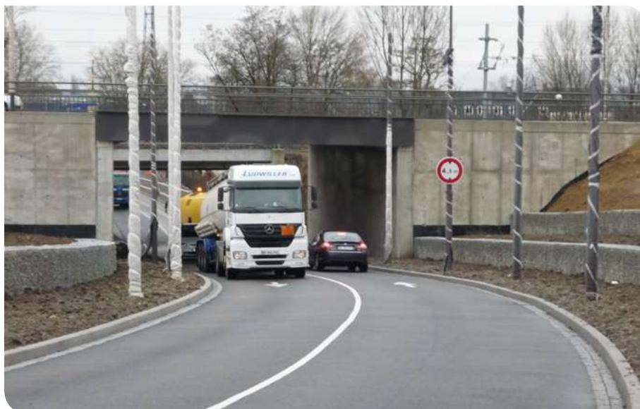
La réalisation de ce tronçon a nécessité des travaux considérables, la construction d'un ouvrage dénivelé sous la RN4, l'abaissement du tablier du pont route du Petit-Rhin, le dévoiement du tracé de la route du Rhin (ex RN4), et cela en maintenant le trafic routier et ferroviaire.
