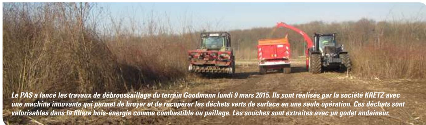
*Le PAS a lancé les travaux de débroussaillage du terrain Goodmann lundi 9 mars 2015. Ils sont réalisés par la société KRETZ avec une machine innovante qui permet de broyer et de récupérer les déchets verts de surface en une seule opération. Ces déchets sont valorisables dans la filière bois-énergie comme combustible ou paillage. Les souches sont extraites avec un godet andaineur.*
